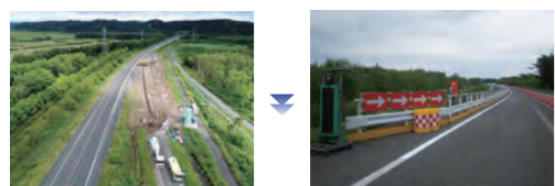
中央分離帯除去、支柱も抜く
