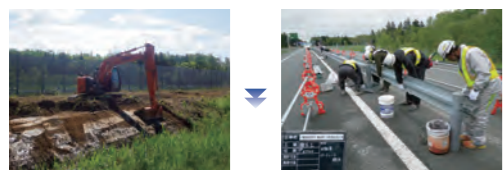
現場事務所の建設
