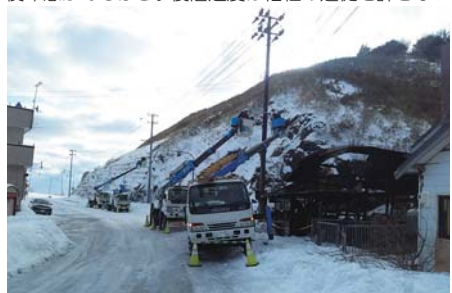
日本最北の礼文島での災害復旧作業現場にて。極寒の通信設備を守る彼らは、まさに北の防人たち。
