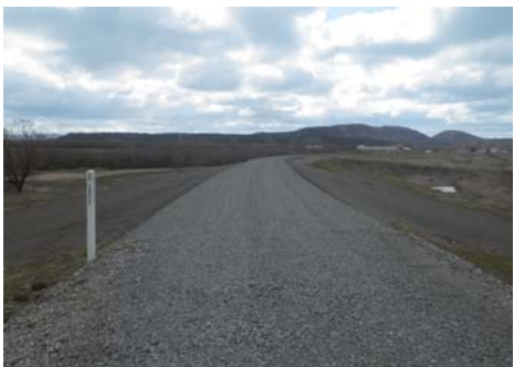
天塩川改修工事の内（雄信内 左岸 築堤工事）比較的最近行われた、天塩川の改修工事にまつわる築堤工事。荒めの吸排水性に優れた粗粒の道が、創業者が建設業界へ参入する前に生業としていた「川砂利」を彷彿させる。守谷建設を象徴する写真に見える。
