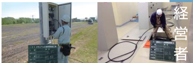
左/雄武町ふるさと100メモリアル広場照明整備工事 盤内の結線 右/雄武浄化センター水処理設備改築更新工事 既設ケーブルの撤去
