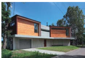
LIM駅新築工事（ニセコ町）
