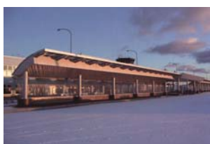
稚内空港駐車場舗道ルーフ新築工事
