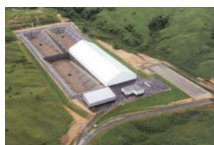
稚内市廃棄物最終処分場建設工事
