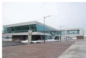
バリアフリー対応旅客施設建設工事（利尻富士町）
