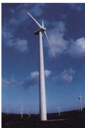
宗谷岬ウィンドファーム建設工事
