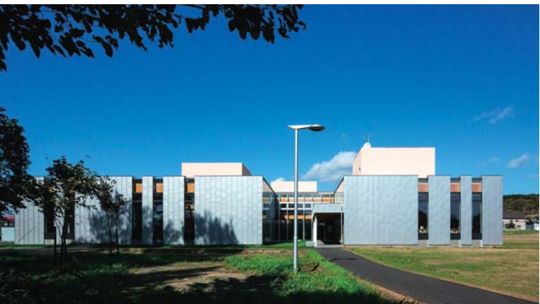
豊富町定住支援センター新築工事 豊富町定住支援センター（撮影：酒井 広司 氏）
