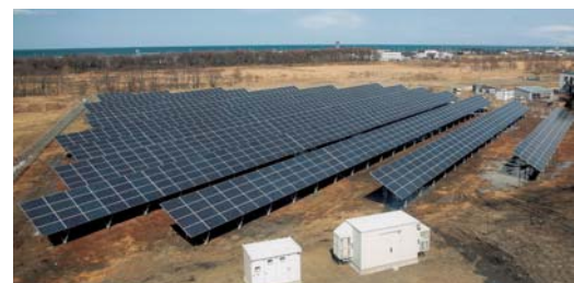
平成25年4月稼働開始／渚滑町1丁目太陽光発電所（紋別市） パネル数290W×1,920枚
