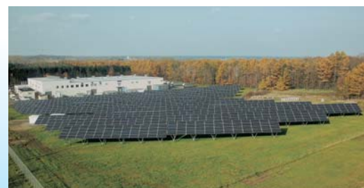
平成25年10月稼働開始／渚滑町8丁目太陽光発電所（紋別市） パネル数290W×2,112枚
